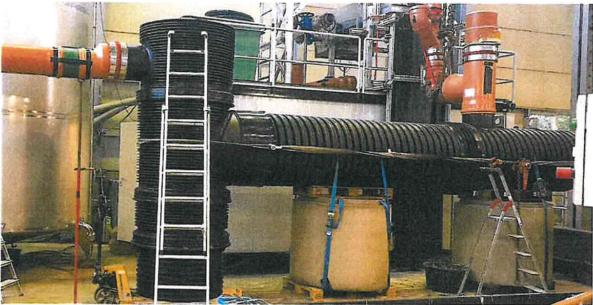
Abb. 2: Niederschlagswasserbehandlungsanlage Certaro 800/6 „begehbar“ aufgebaut im IKT-Prüfstand während der Versuchsdurchführung.
