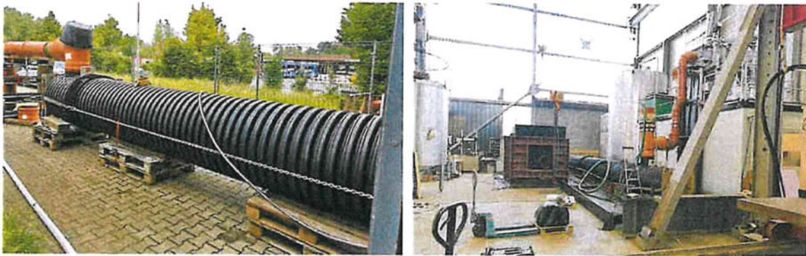
Abb. 1: Niederschlagswasserbehandlungsanlage Certaro 800/21 „Standard“ aufgebaut im IKT-Prüfstand während der Versuchsdurchführung mit Blick (links) auf den Anlagenteil außerhalb der Halle mit Auslauf und Probenahmestelle und Blick (rechts) auf die Zudosierung in der Versuchshalle.
