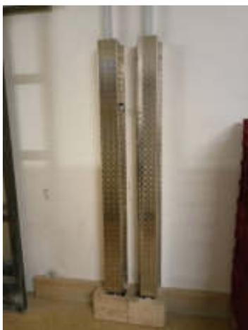
Bild 3: Verkofferung der Sammelleitung mit Riffelblech-Rammschutz und Sockelrammschutz mit Holz
