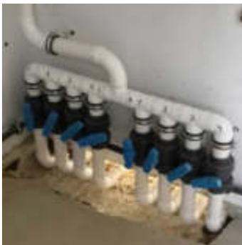
**Bild 1:** Sammler mit Kugelhähnen
